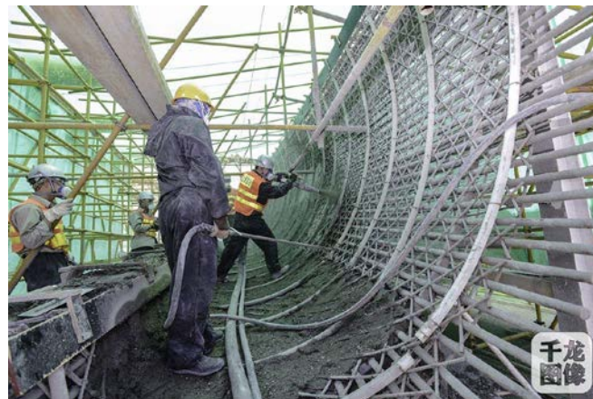
滑道蒸发管的施工
